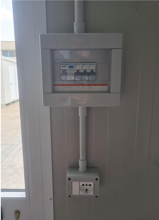
**Impianto elettrico standard norma CEE 220V, con tubo PVC a vista, compreso di:**
