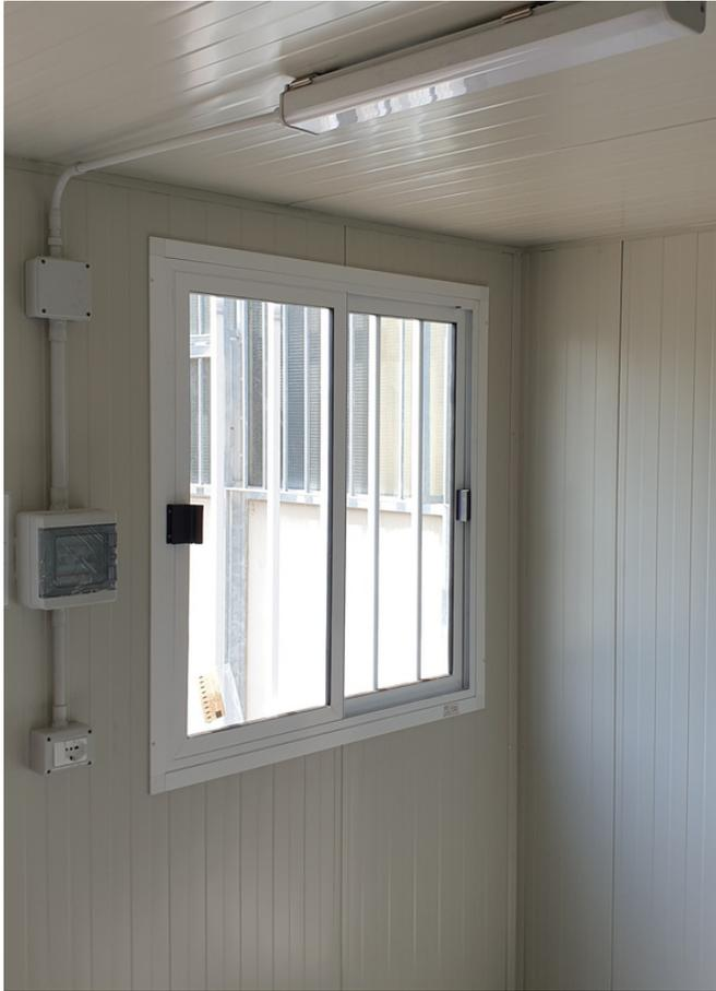
**Impianto elettrico standard** norma CEE 220V, con tubo PVC Bianco a vista, compreso di:
